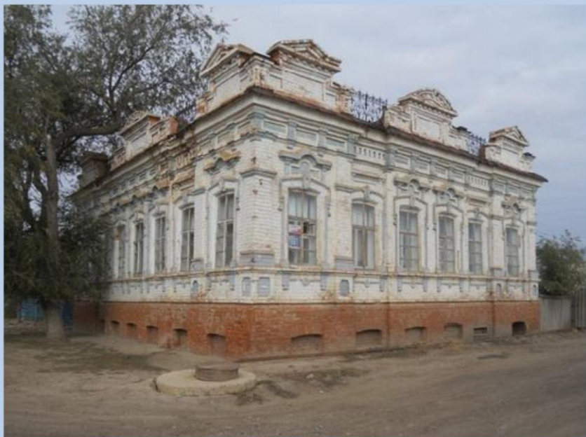
Музей краеведения, построен в 1898 г., с. Александров Гай, Александрово-Гайский район
