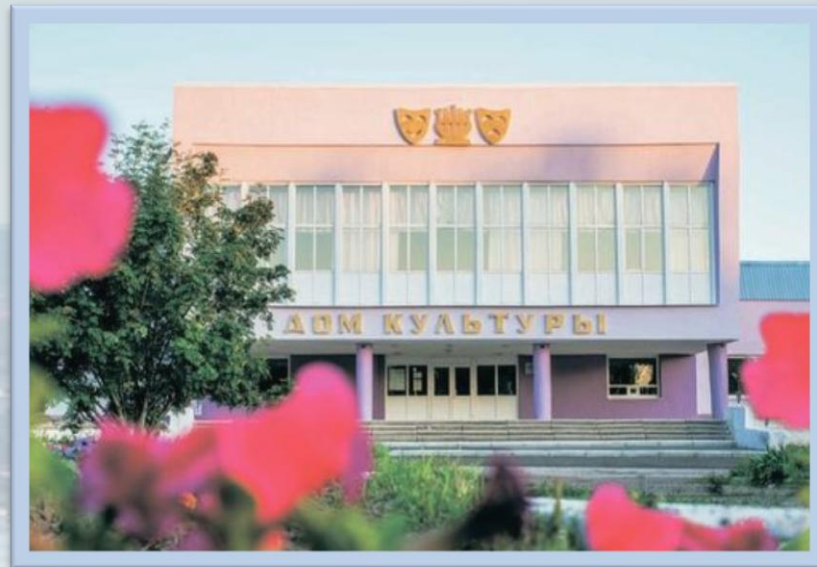
Районный Дом культуры, г. Ершов, Ершовский район
