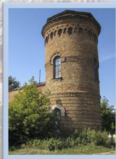
Водонапорная башня станция Урбах, пгт. Пушкино, Советский район
