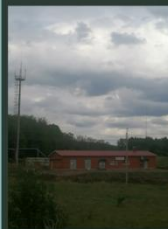
КНС-кустовая насосная станция
