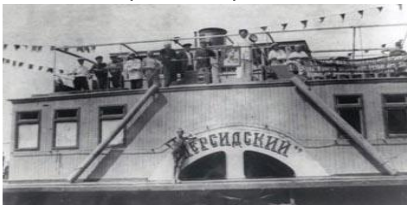
Фрагмент переправы «Персидский»
