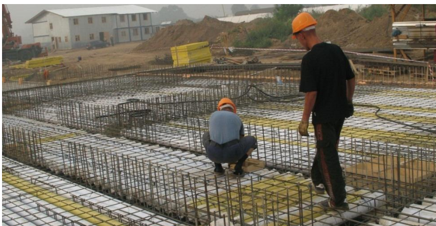
Рис. 4. Армирование многопустотной монолитной плиты
