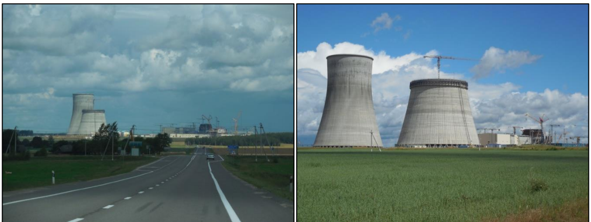
Рис. 3. Строительная площадка Белорусской АЭС (фото автора)
