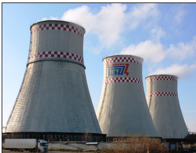
Рис. 5. Градирни Минской ТЭС-4 (фото сотрудников электростанции)
