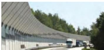
Рис. 1. Акустический экран на съезде с МКАД
