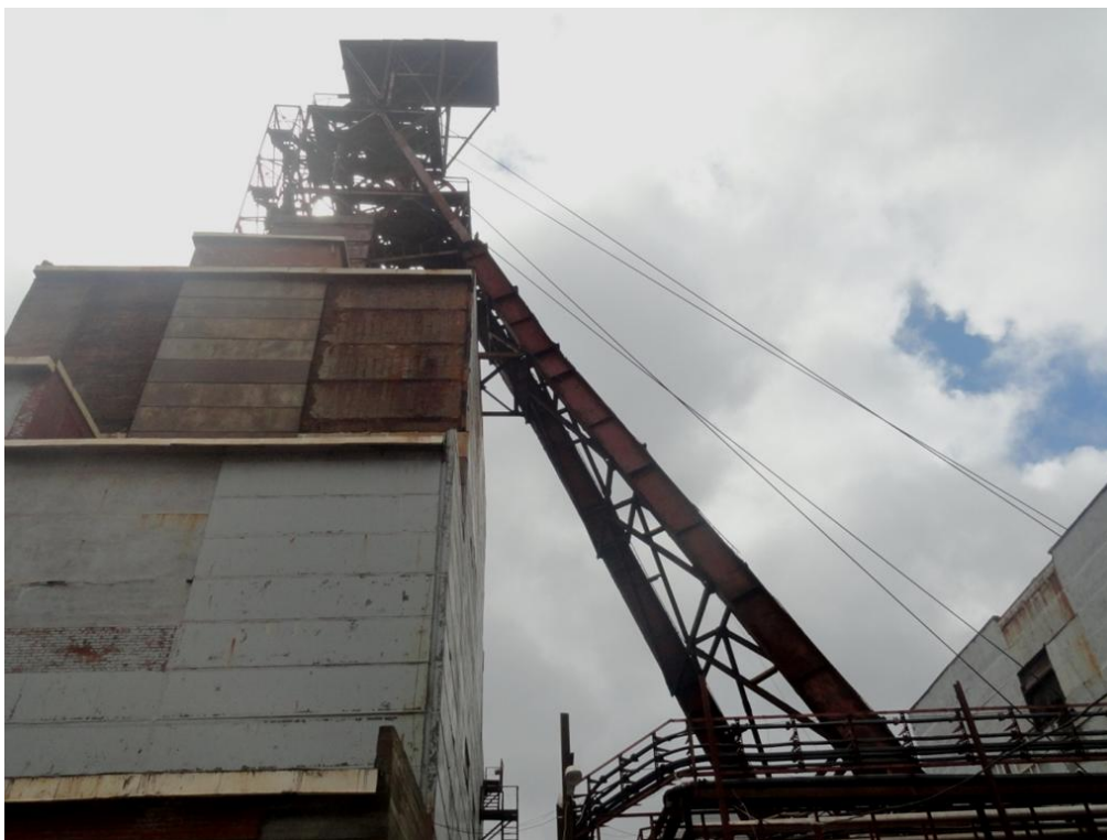
Рис. 1 – Общий вид обследуемого копра
