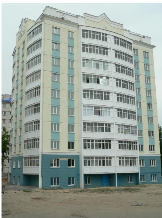
Рис. 1. Общий вид жилого дома
