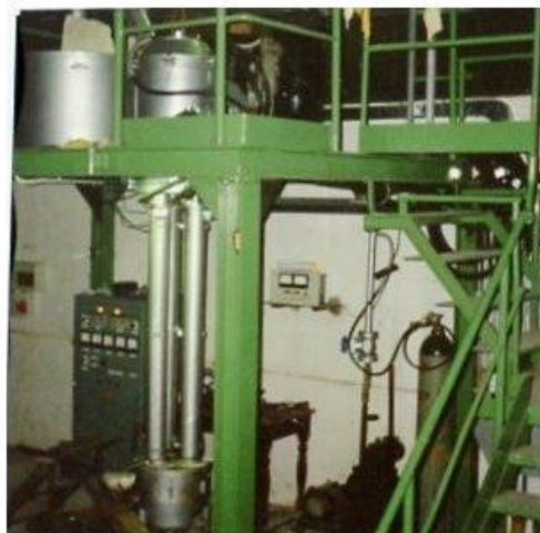
Рис. 4. Фото вакуумного аппарата при монтаже на фирме Италии
