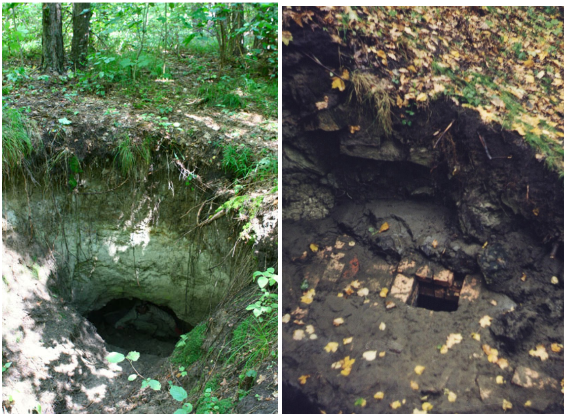
Рис. 4. Вход в штольню до и после реконструкции
