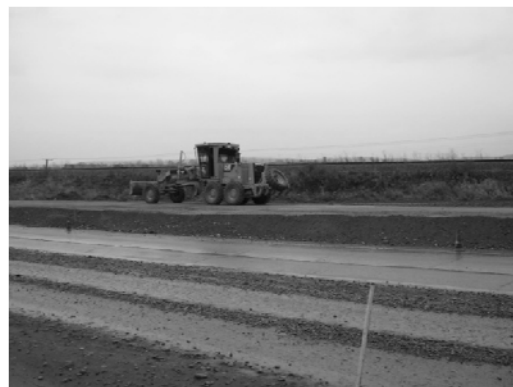
Рис. 2. Укладка основания дорожной одежды на опытных участках автогрейдером
