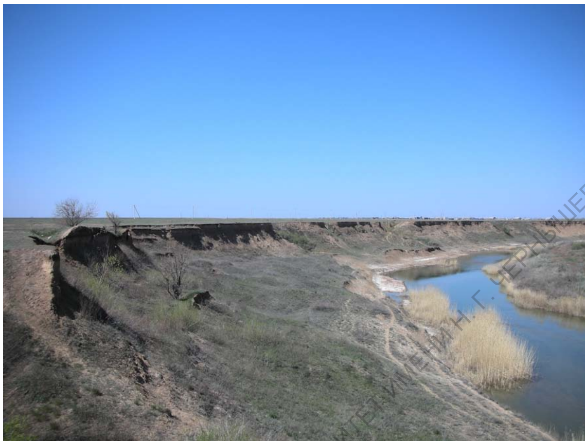
Рис. 2.5. Правый берег реки Большой Узень с оползневymi телами. Фото Н. В. Пичугиной (2010 г.).
