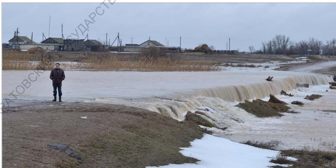
Резкий подъём воды в степной балке в результате весеннего снеготаяния в апреле 2014 г. вызвал размыв дороги у с. Семёновки
