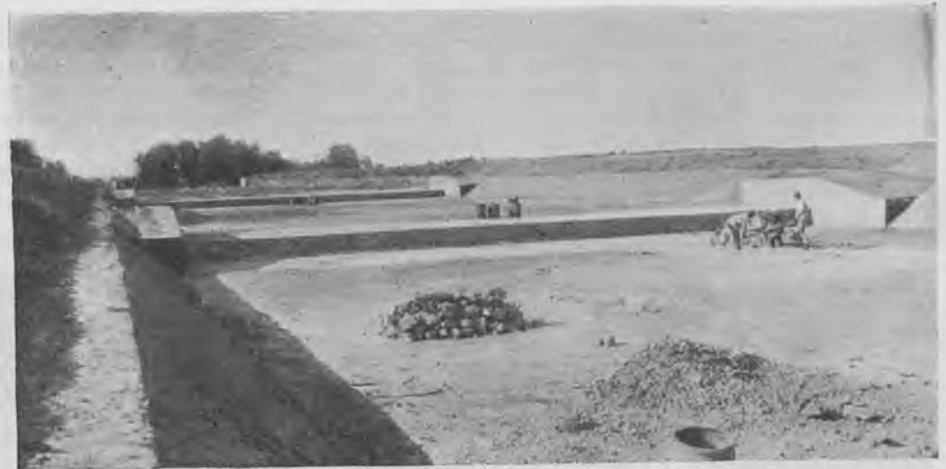
Каменно-бетонный водослив при плотине Тингутинского водохранилища.
