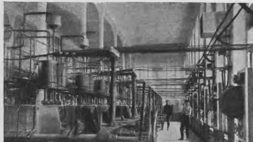
Электролитический способ добычи водорода на заводе им. Вахитова.
