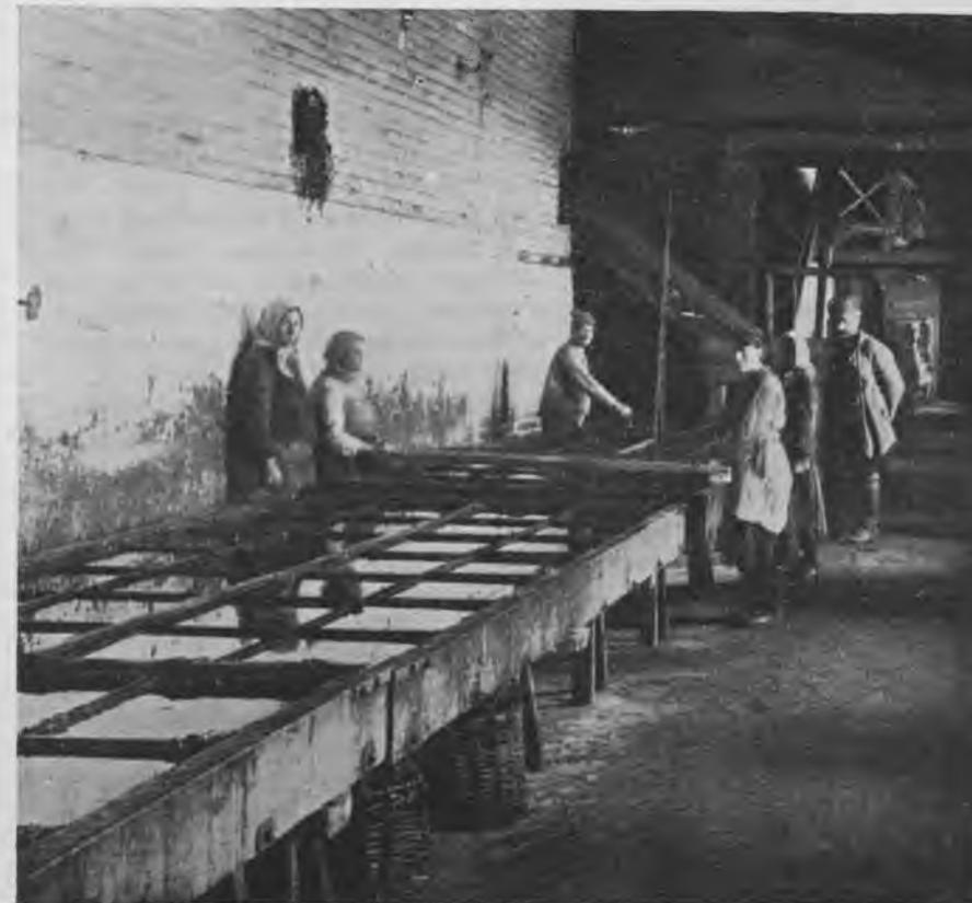
Резка готового клея.
