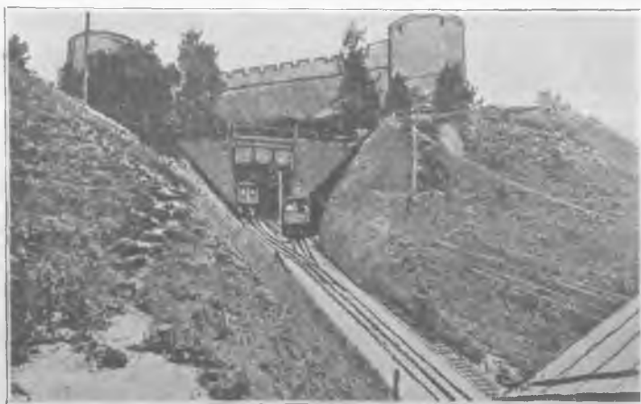
Рис. 28. Элеваторъ электрической ж. д.
